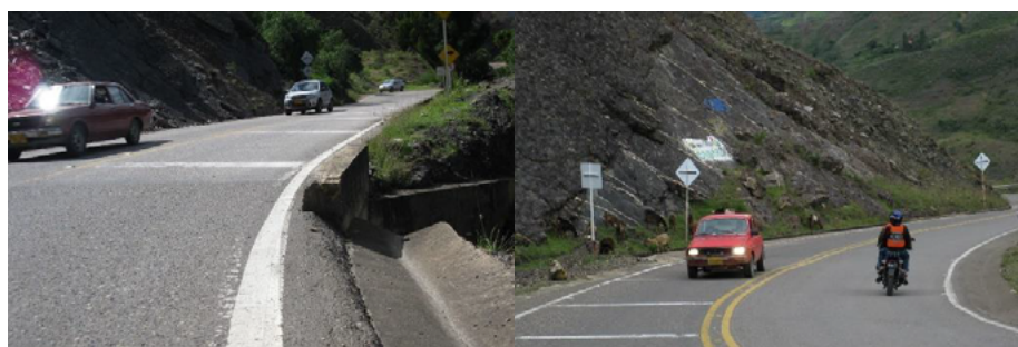
Figura 2. Curvas sin suficiente entretangencia horizontal
